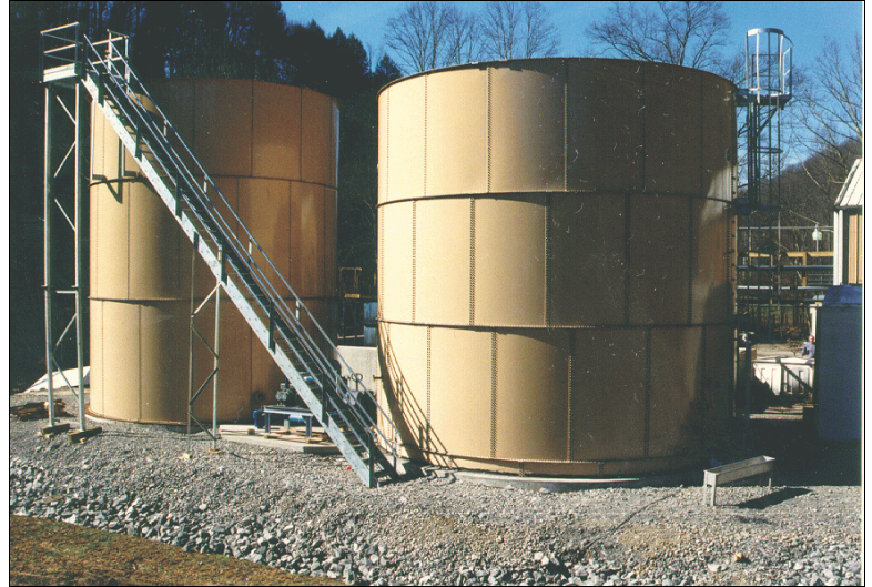
SBR e híbrido en construcción
